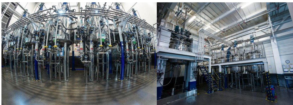
证明材料 27 合浆工序现场照片
