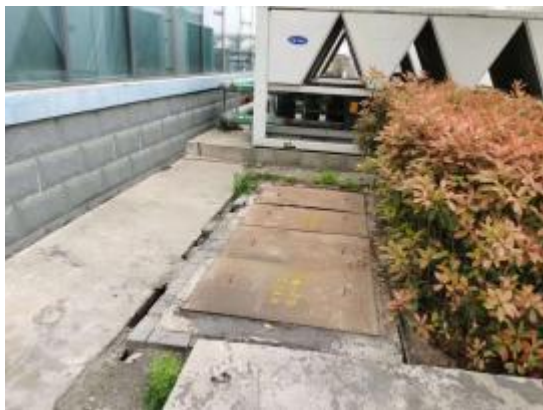
NMP 回收装置旁事故池
