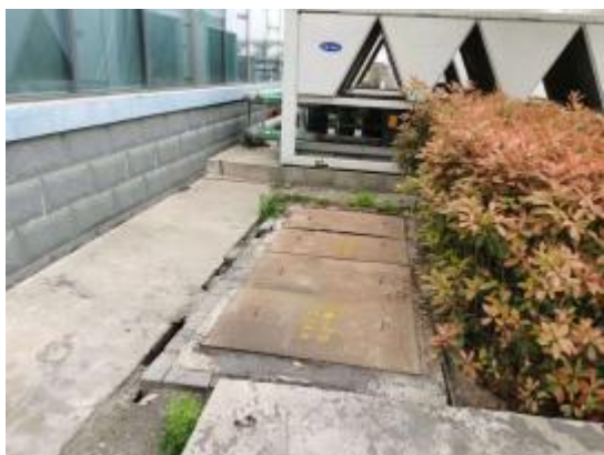
NMP 回收装置旁事故池
